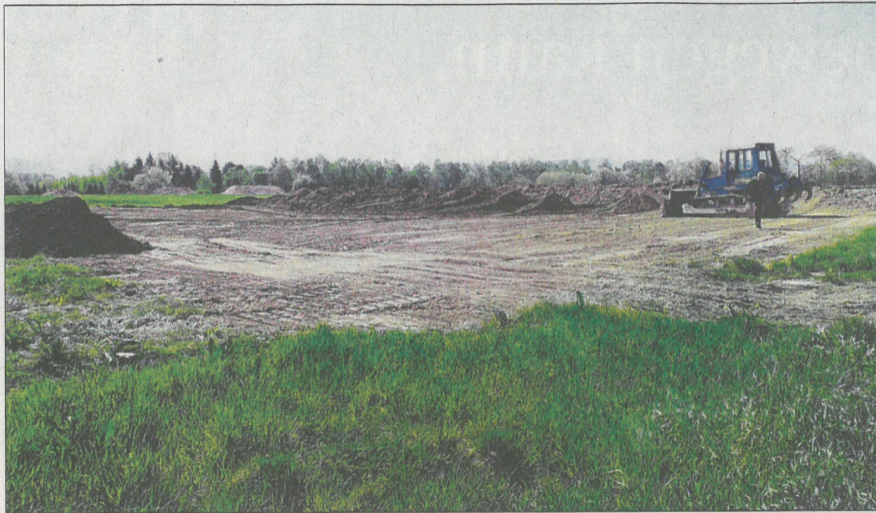
31 000 QUADRATMETER GROSS ist das Grundstück im Ötigheimer Industriegebiet, auf dem die Spedition Hartmann eine neue Logistikhalle baut.
