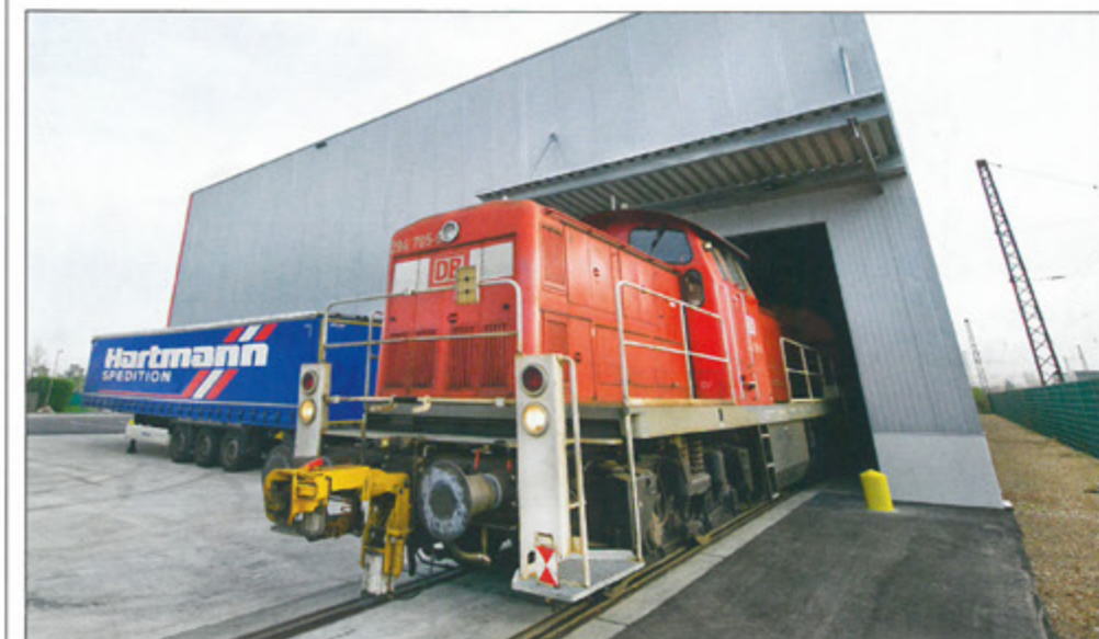
Abb. 3: Eine DB-Lok rangiert Waggons in die Coilhalle.
